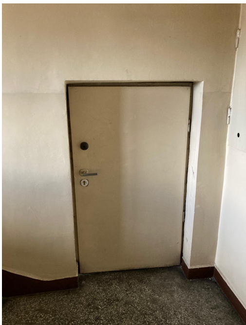
Fot. 5 Istniejące drzwi do pom. technicznego
