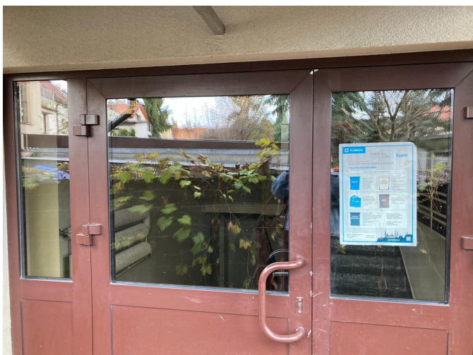
Fot. 3 Istniejące drzwi wejściowe
