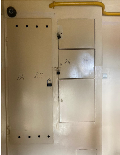
Fot. 8 Istniejąca szafa z licznikami gazu oraz fragment poziomej trasy instalacji
