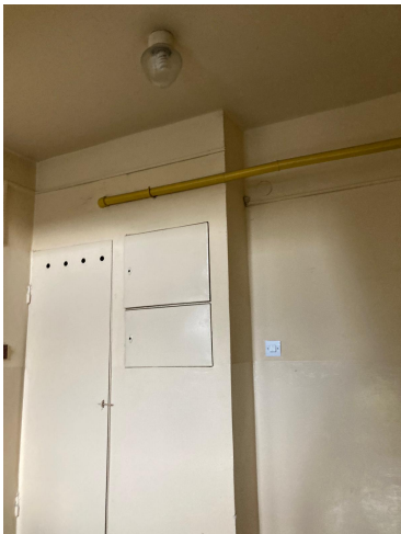
Fot. 6 Istniejąca lampa, skrzynki elektryczne, łącznik oświetlenia
